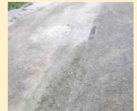
Caniveau obstrué par du ghorre en pente
