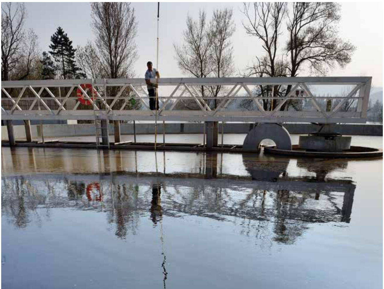
Clarificateurs de la station de traitement des eaux usées à Fleurieu/Neuville
