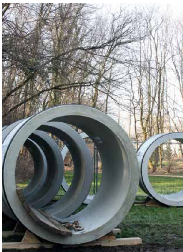
Chantier du collecteur de l'Yzeron.
