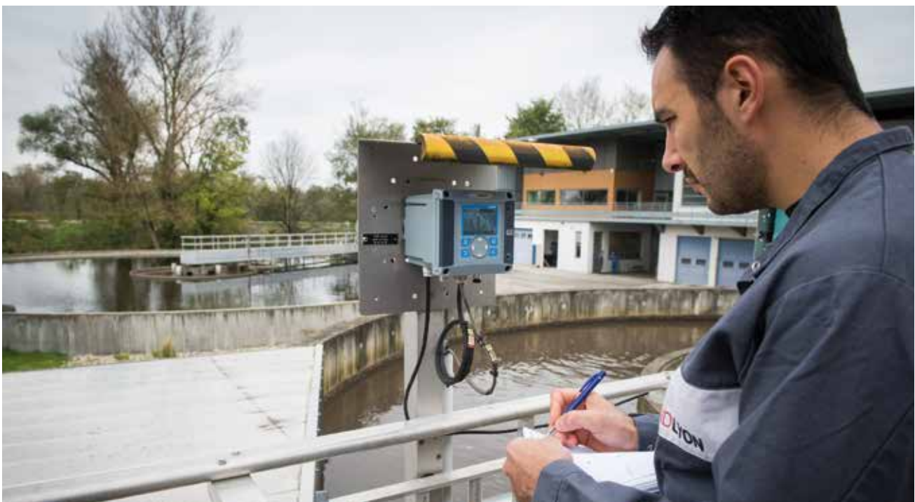
Agent de la station de traitement à Jonage
