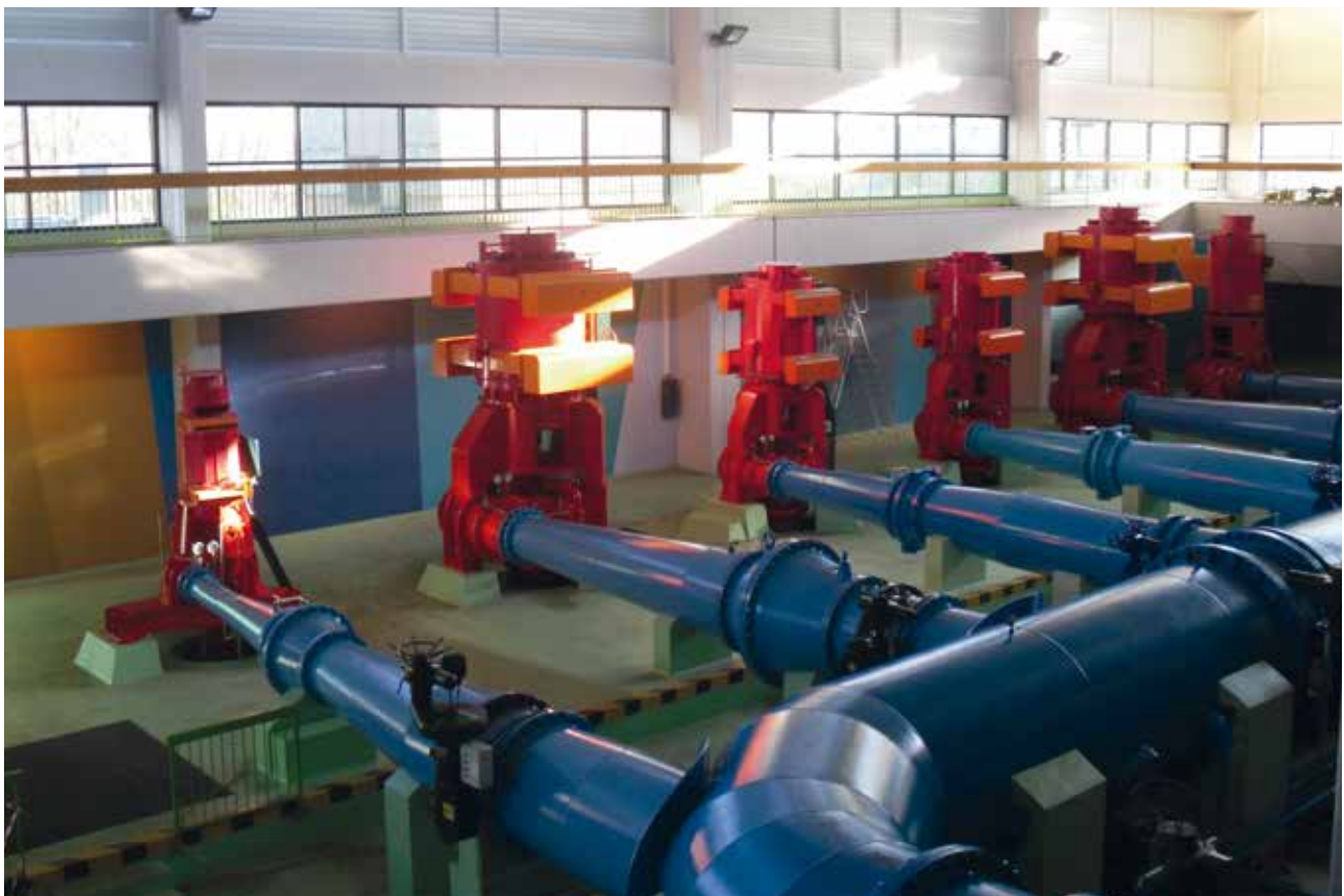
Usine des eaux de Croix-Luizet (Villeurbanne).
