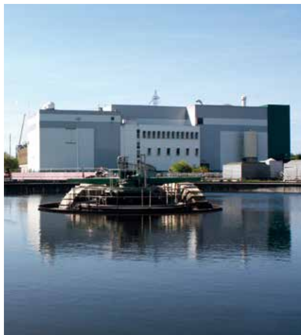
Station de traitement des eaux usées à Saint-Fons
