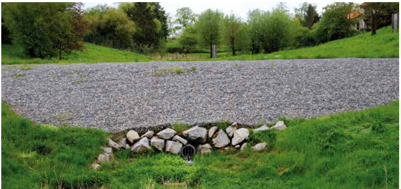
Aménagement de rétention et de traitement des eaux pluviales à Dardilly
