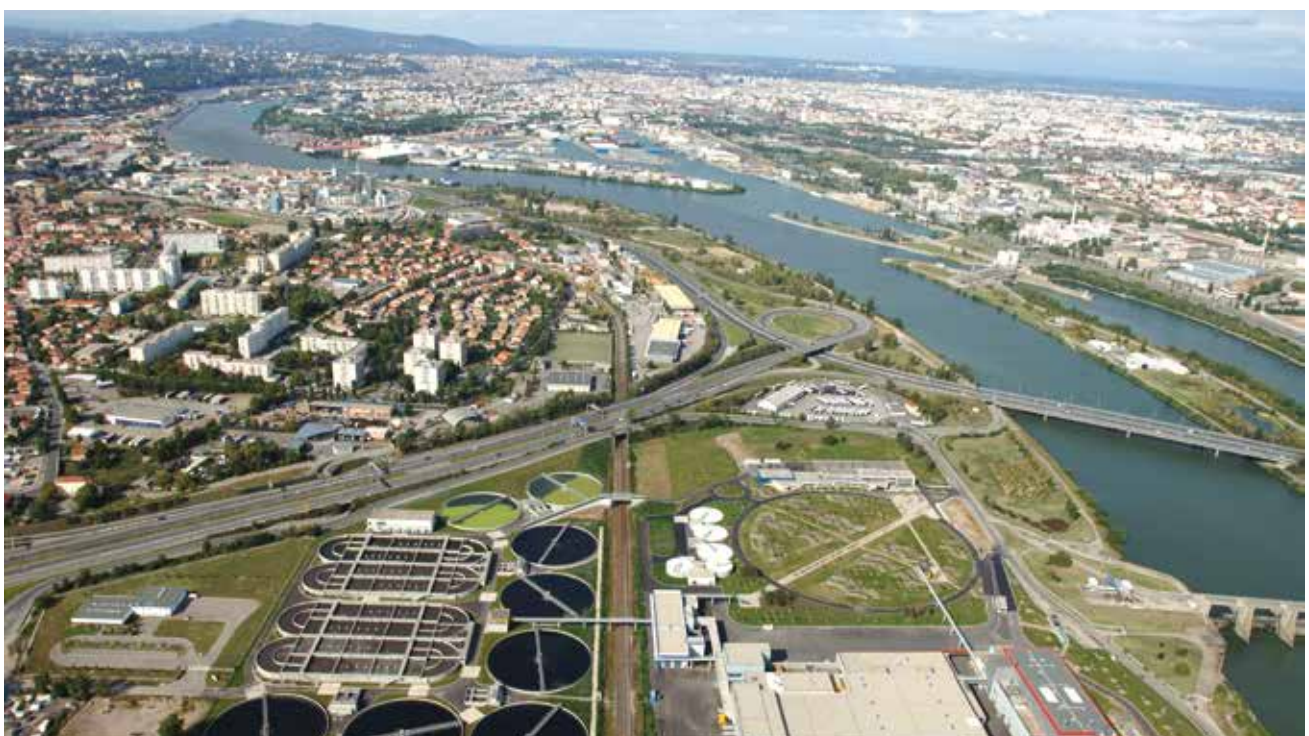
Station de traitement des eaux usées à Pierre-Bénite
