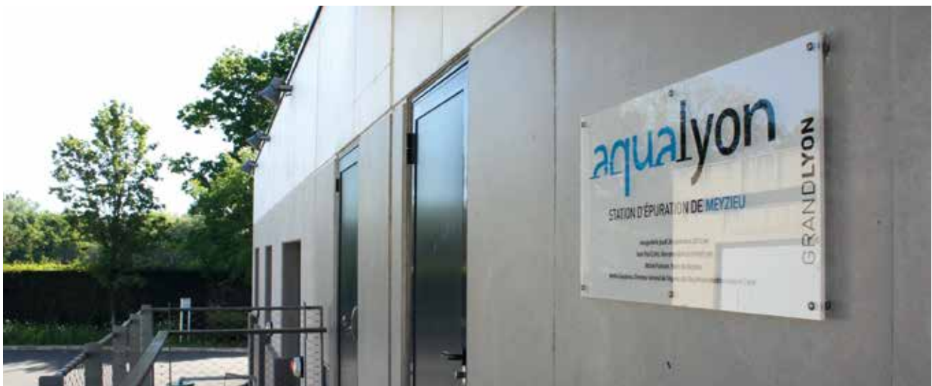
Station d'épuration de Meyzieu.
