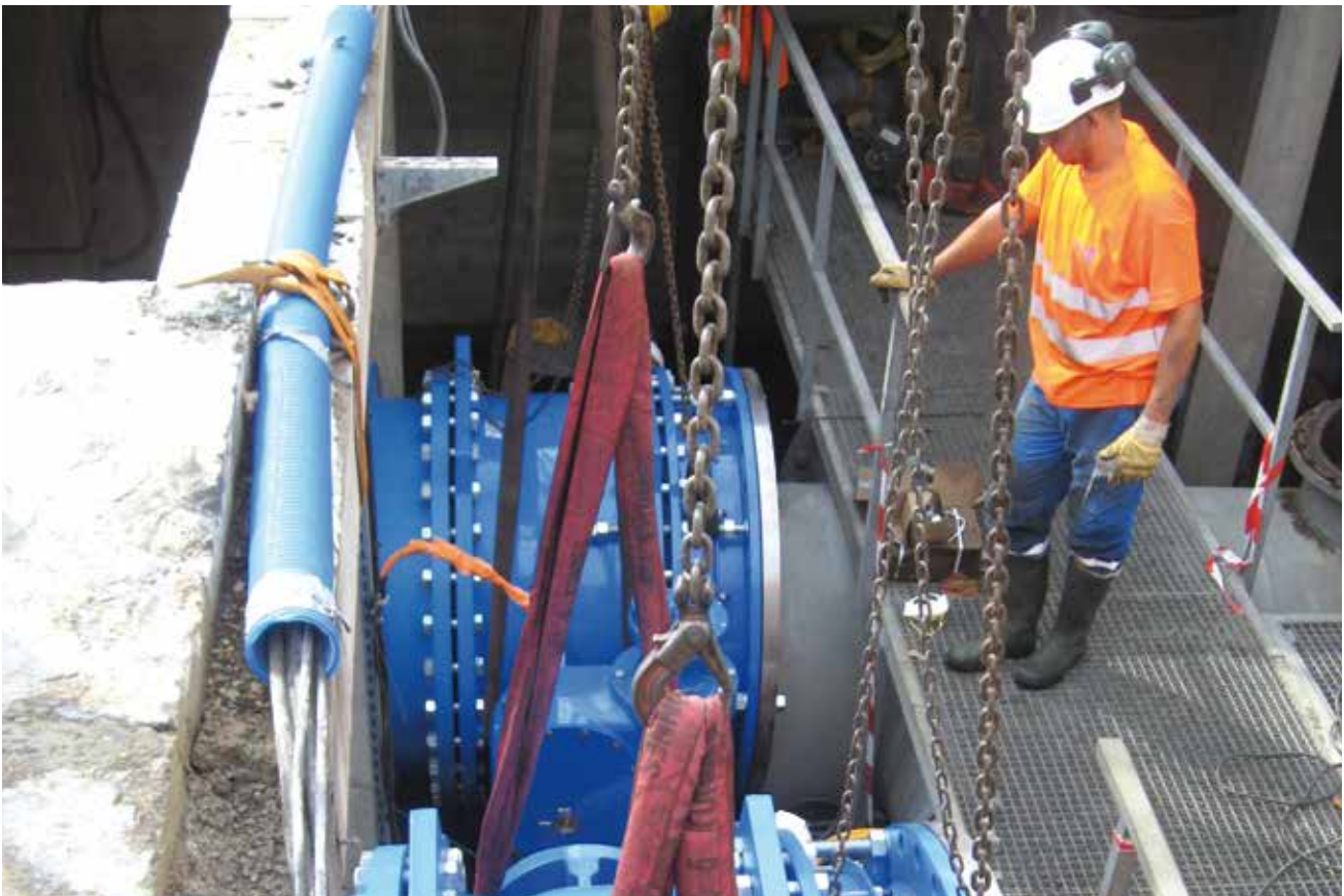
Remplacement d'une vanne
