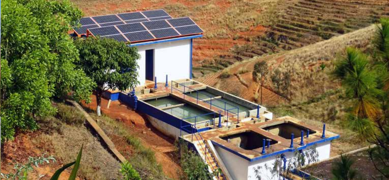
Station de traitement d'eau potable de Soarano.
