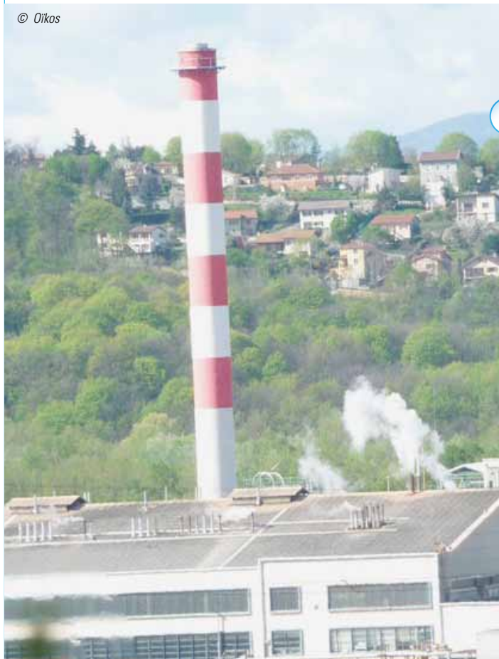
Cheminée d'usine vue de Saint-Fons
