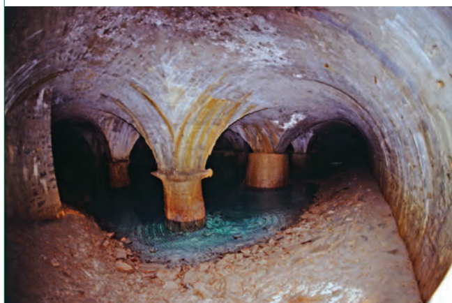
Un exemple de site souterrain artificiel : le réservoir de l'ancienne usine d'eau de Saint-Clair à Caluire-et-Cuire
