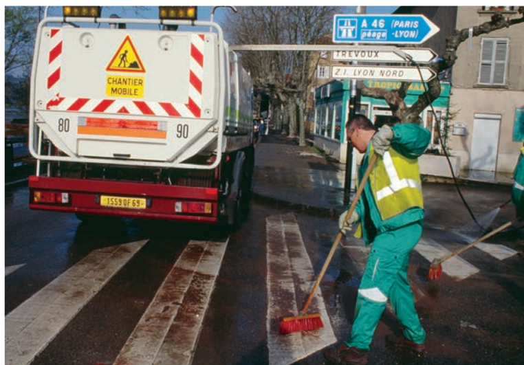
4604W024 - Nettoyement de la chaussée après inondation (2001).
