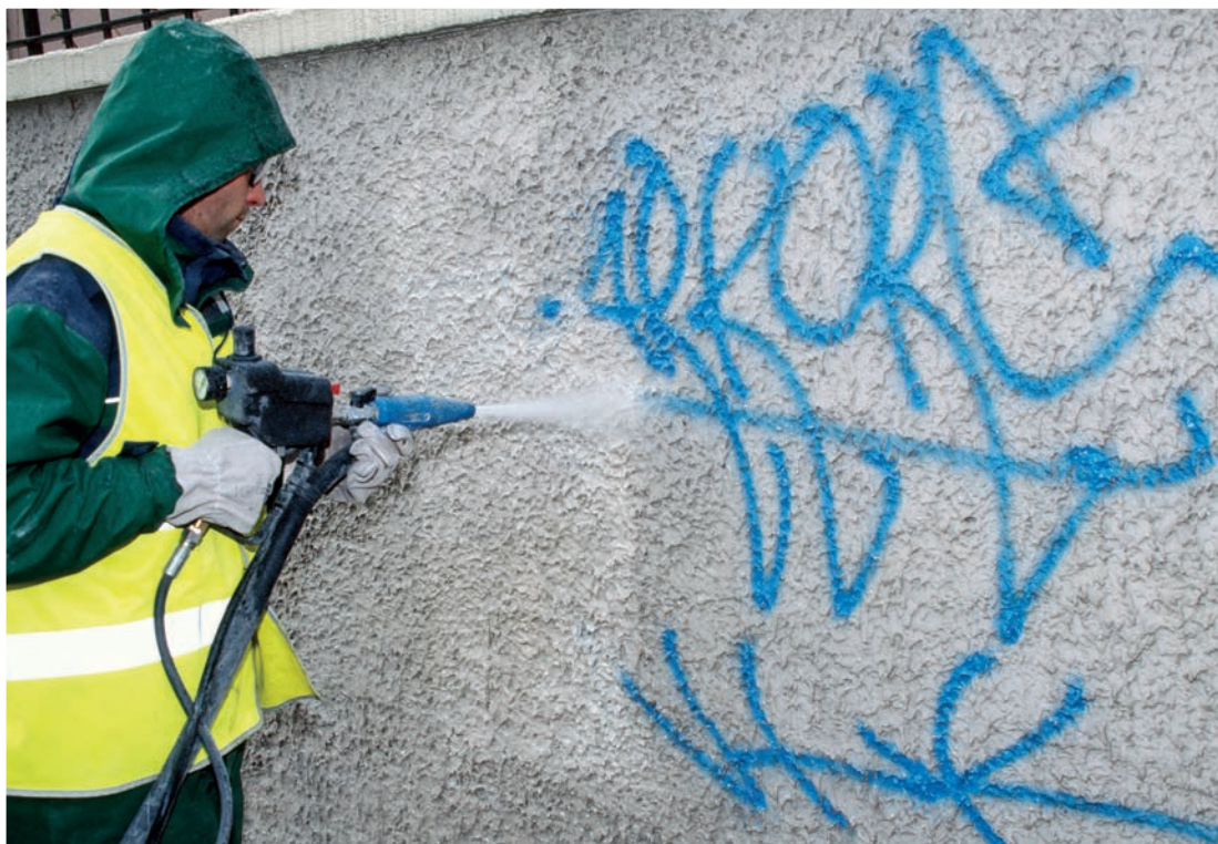
4585W003 - Nettoient d'un mur tagué par hydrogommage rue du Commandant Charcot, Lyon 5e (1998).
