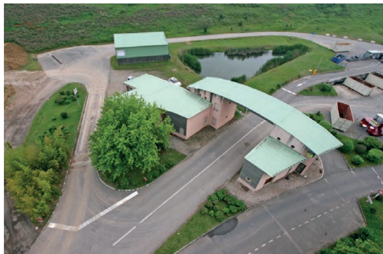
5103W009 - Vue aérienne de la déchèterie de Genas (2013). © Communauté urbaine de Lyon - Auteur inconnu.
