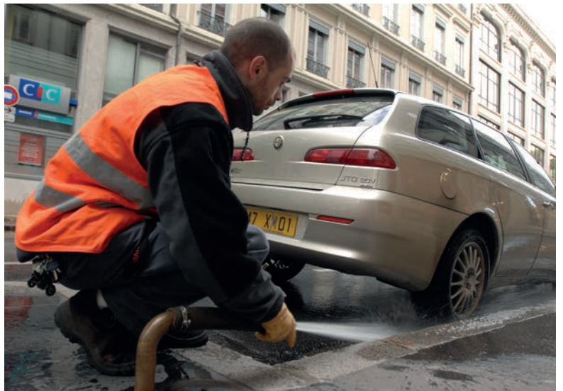
4613W002 - Nettoyement des caniveaux à l'eau (2009).
