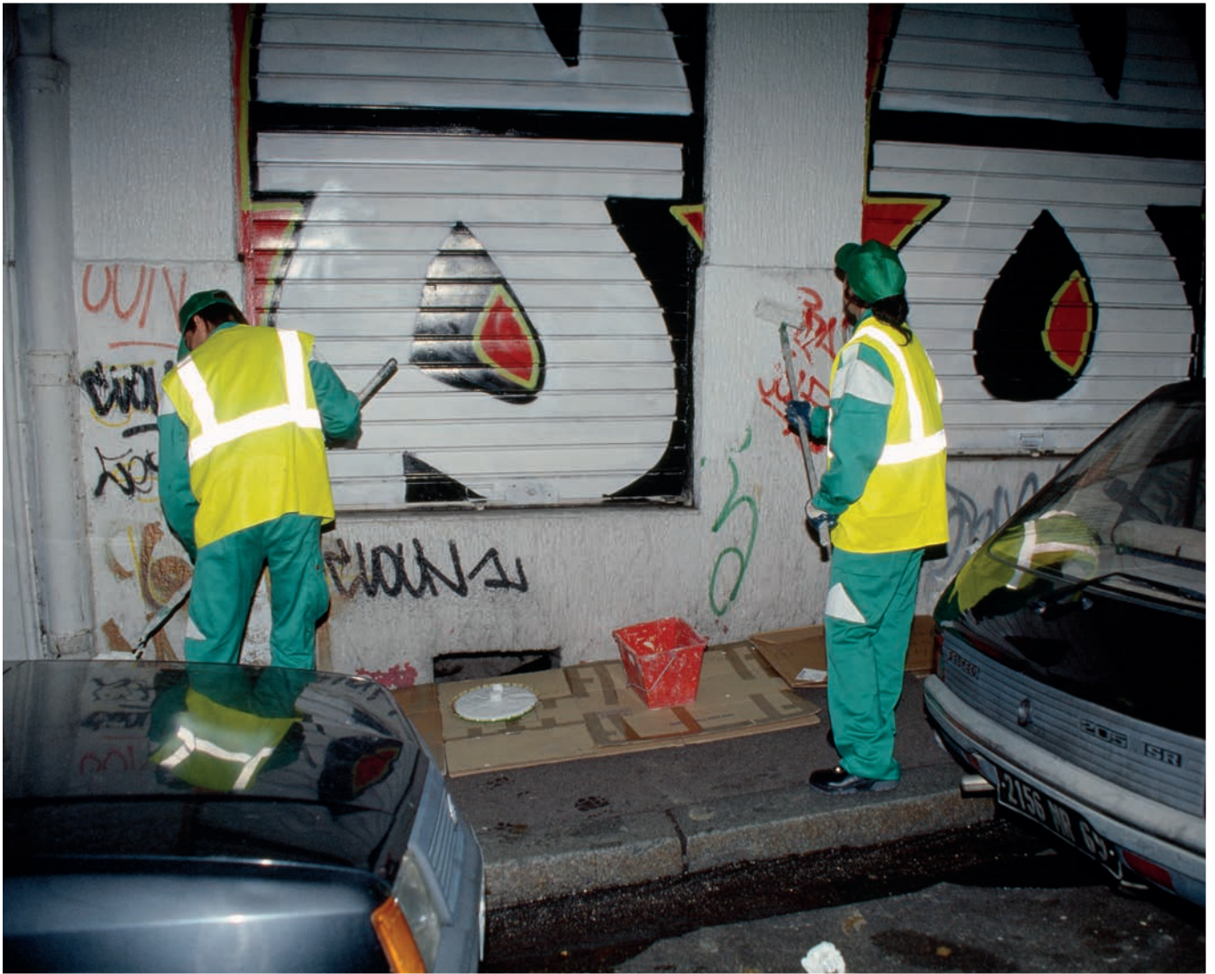
4586W012 - Rafrâichissement de façade sur mur tagué, Lyon 1er (2001).
