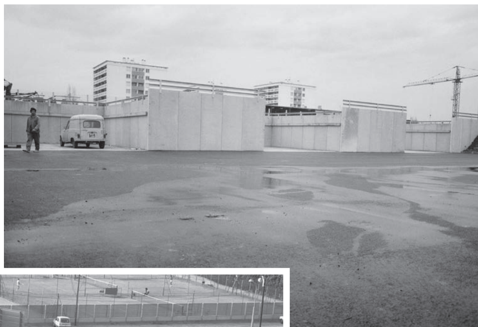
4788W003 - Chantier d'aménagement de la déchèterie de Pierre-Bénite (1988).
