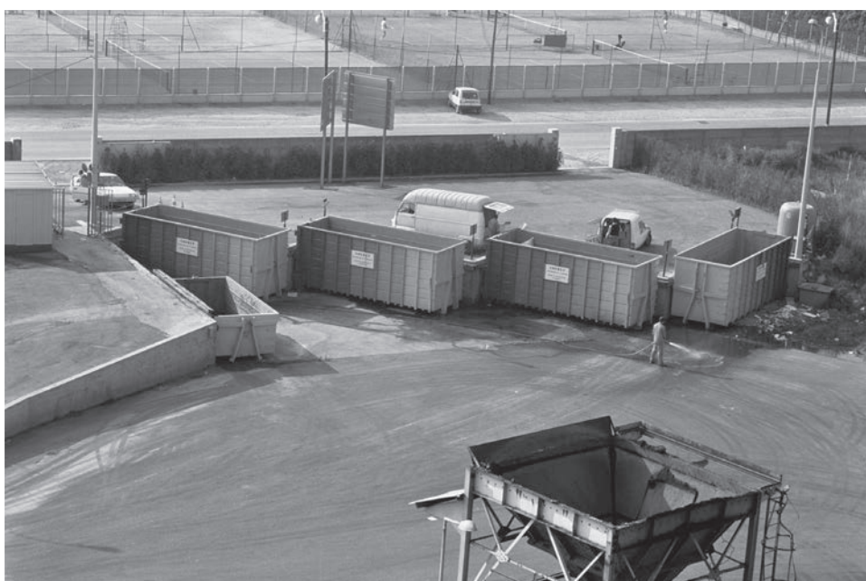
4801W004-2 - Vue générale de la déchèterie de Gerland depuis l'usine d'incinération de Gerland, Lyon 7ème (1986).
