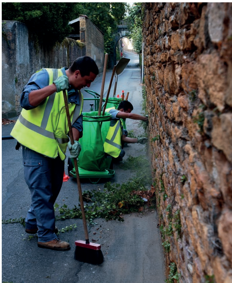
4812W012 - Désherbage manuel et ramassage des déchets végétaux (2004).
