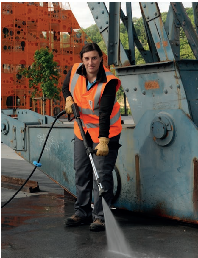
4619W024 - Nettoyement au jet haute pression des rebords d'une structure en fer (2011).
