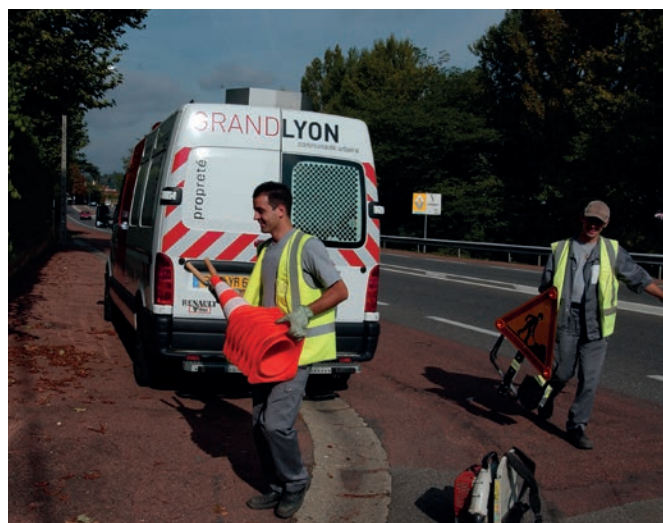
4812W003 - Mise en place du matériel avant chantier à Collonges au Mont d'Or (2004).
