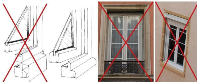
Les éléments d'occultation sont divers sur les Pentes : volets, contrevents, jalousies, lambrequins, persiennes... tous ne sont toutefois pas adaptés à tous les immeubles. Les volets roulants sont proscrits sur les immeubles non équipés d'origine.
