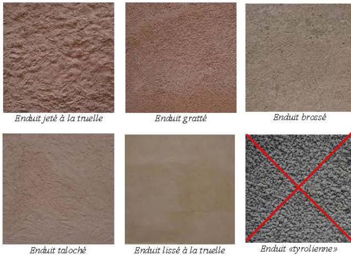
Les édifices en moellons de pierre devraient être enduits, afin d'être protégés de la pluie. Les édifices en pierre de taille n'ont pas besoin d'être enduits.
