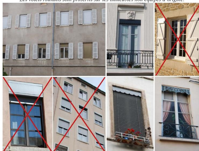
Les éléments d'occultation sont divers sur les Pentes : volets, contrevents, jalousies, lambrequins, persiennes... tous ne sont toutefois pas adaptés à tous les immeubles. Les volets roulants sont proscrits sur les immeubles non équipés d'origine.
