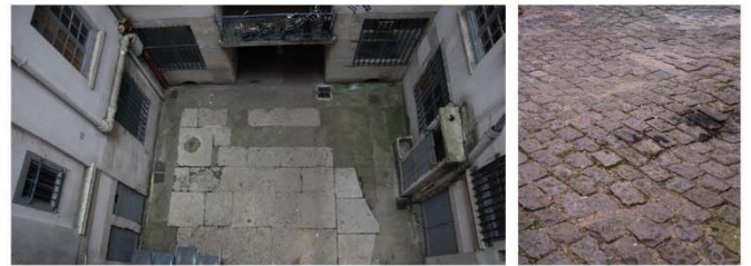
Quelques revêtements de sols traditionnels lyonnais, équipant rues, places et cours.
