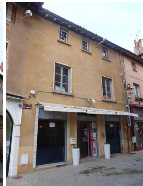
Les enduits traditionnels ne sont pas particulièrement bien représentés sur les deux communes. En bas à gauche, un enduit traditionnel à la chaux.
