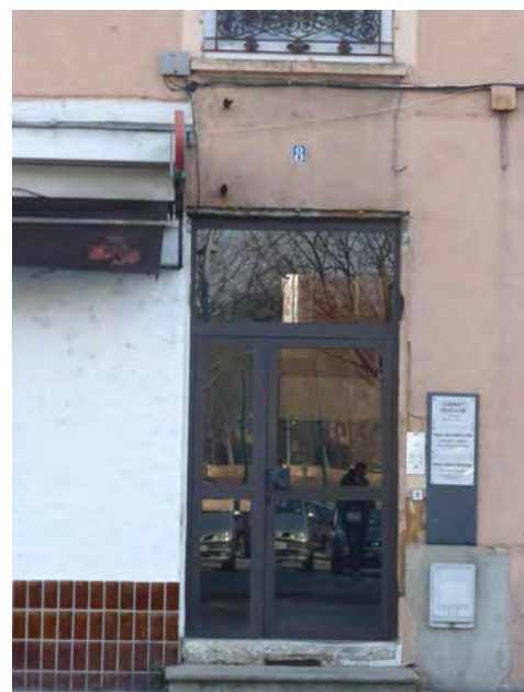
Divers désordres en lien avec des produits manufacturés : portes «du commerce» vitrées ou sans liens avec le bâti, volets dits «Z», fenêtres en PVC posées en rénovation.
