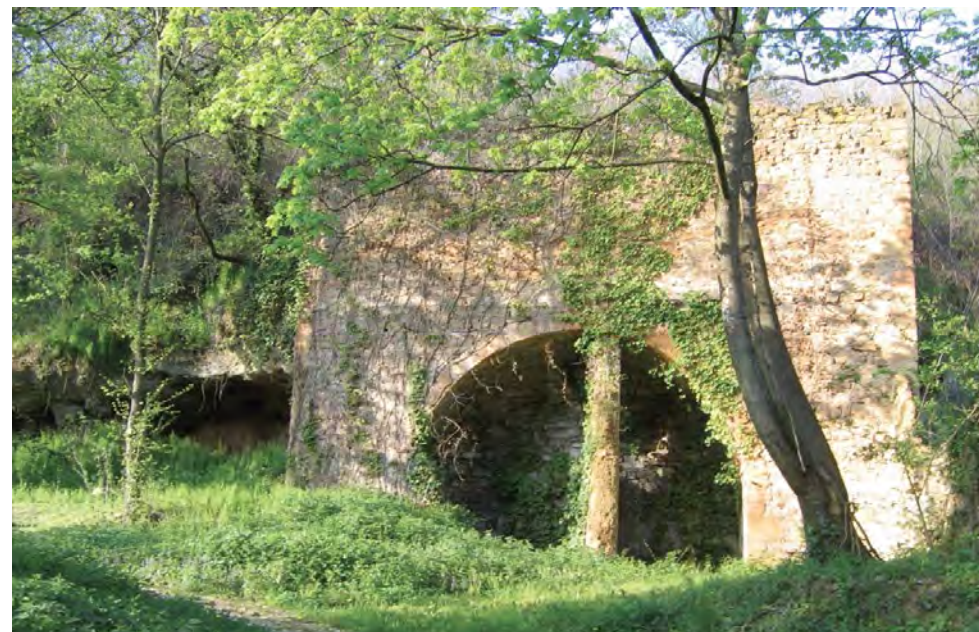
En haut : le mur de soutènement du jardin haut du château d'Ombreval. En bas : infrastructure du château de Montanay.
