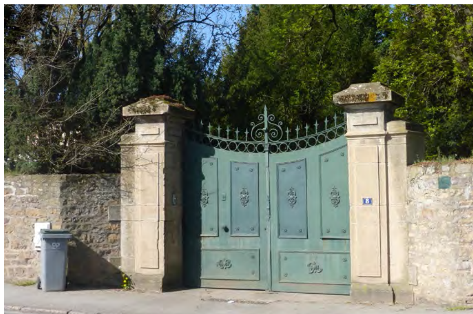
Les ferronneries sont des éléments bien représentés : portails, appuis de fenêtres, rambardes de balcons..
