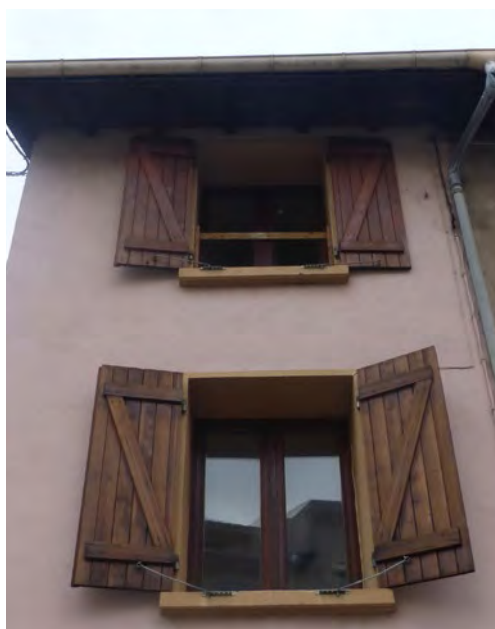
Divers désordres en lien avec des produits manufacturés : portes «du commerce» vitrées ou sans liens avec le bâti, volets dits «Z», fenêtres en PVC posées en rénovation.
