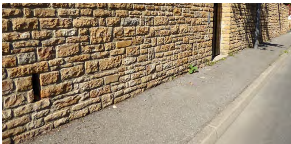
En haut : Projet de zonage de ruissellement dans le cadre du PLU 2015 – Source : Grand Lyon En bas : percements dans les soutènements permettant l'évacuation des eaux.
