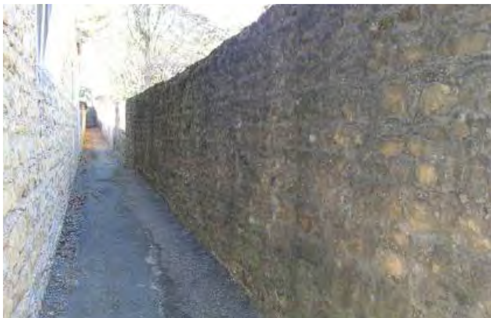
Les lits de galets, en alternances avec d'autres matériaux, sont très usités. On les retrouve également, ponctuellement, dans les murs en pisé (ici le mur du chemin Saint-Jacques, à Villevert.)
