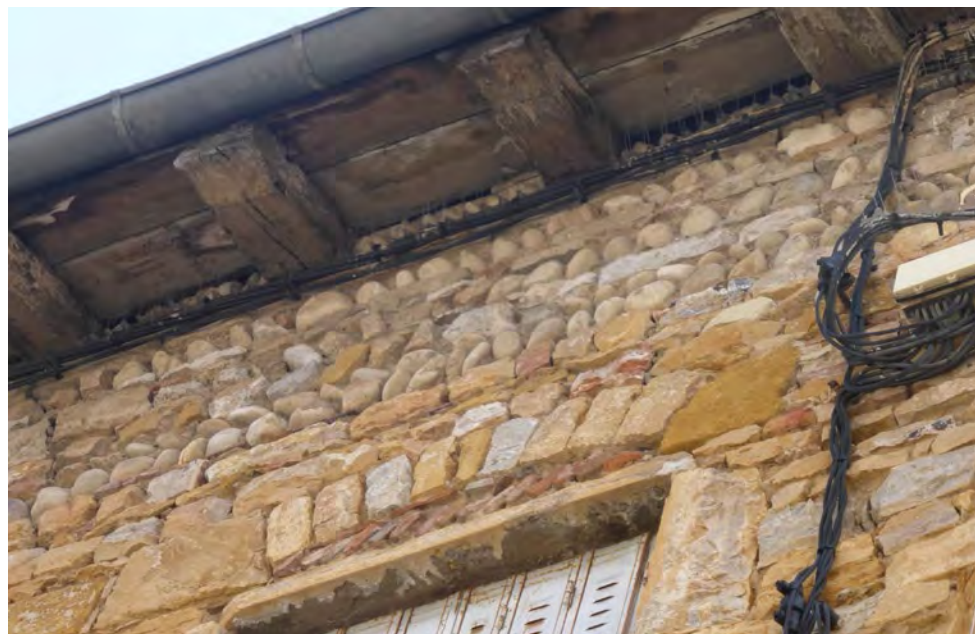
La pierre de Couzon est majoritairement utilisée en moellons. Elle doit être préférentiellement enduite. Les galets sont également employés, récupérés dans les lits de Saône ou ruisseaux locaux.
