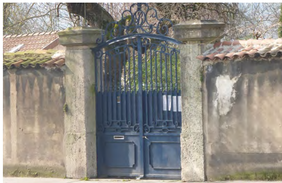
Différents murs de clôture, et leurs portails et ferronneries associés. Ces trois éléments forment un corpus conférant aux communes une forte identité paysagère et urbaine.
