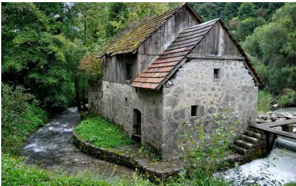
L'énergie hydraulique peut être exploitée sous formes de micro-centrales privées.
