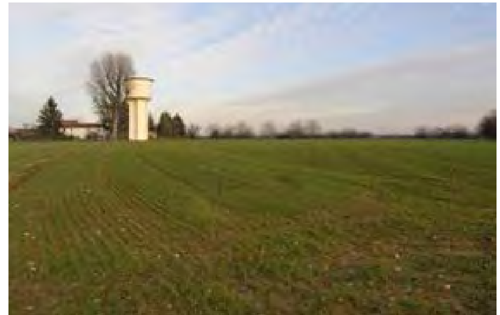
Le plateau n'est que faiblement urbanisé. On y trouve quelques fermes, et un château d'eau.
