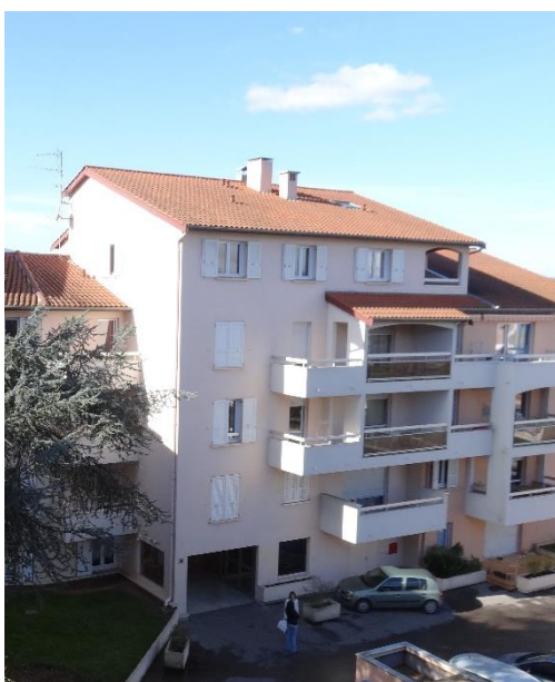
10 logements rue Joliot Curie – Lyon 5 ème (acquisition Alliade Habitat)
