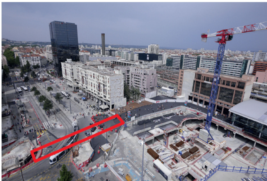
Emprise du chantier sur le boulevard Vivier Merle
