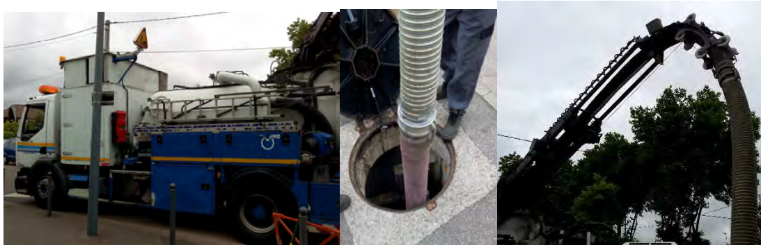
Figure 13 : Curage par camion à haute pression (Crédit photos : Grand Lyon)
