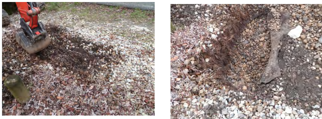
Figure 9 : Réalisation d'un sondage à la pelle mécanique sur la tranchée rue de l'Aviation
