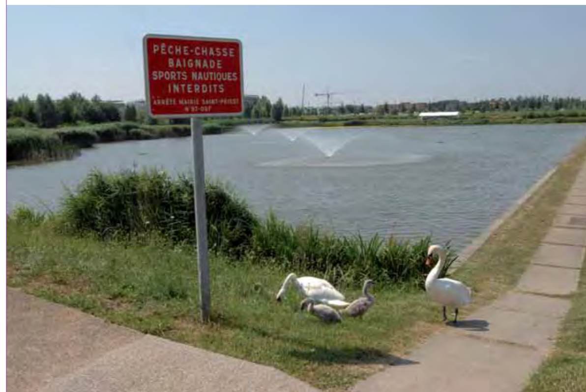
Les bassins de régulation de l'eau du Parc technologique de Saint-Priest : un aménagement hydraulique colonisé spontanément par la faune. © Jacques Léone - Grand Lyon
