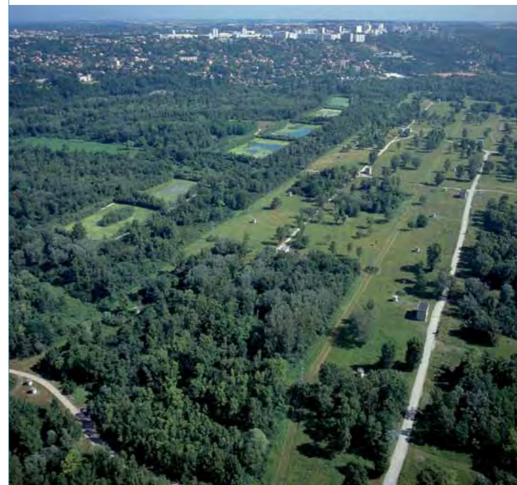
Le champ captant de Crépieux-Charmy : on distingue les alignements de puits de captage, la mosaïque d'habitats ouverts ou boisés et, au second plan, la cotière de la Dombes et la ville nouvelle de Rillieux-la-Pape. © Jacques Léone - Grand Lyon
