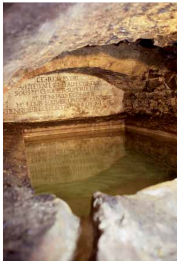
■ L'agglomération lyonnaise recèle un important réseau de galeries et ouvrages souterrains, tel ce réservoir d'eau établi en 1777 dans le sous-sol de l'ancien hôpital de l'Antiquaille à Lyon. © Jacques Léone - Grand Lyon
