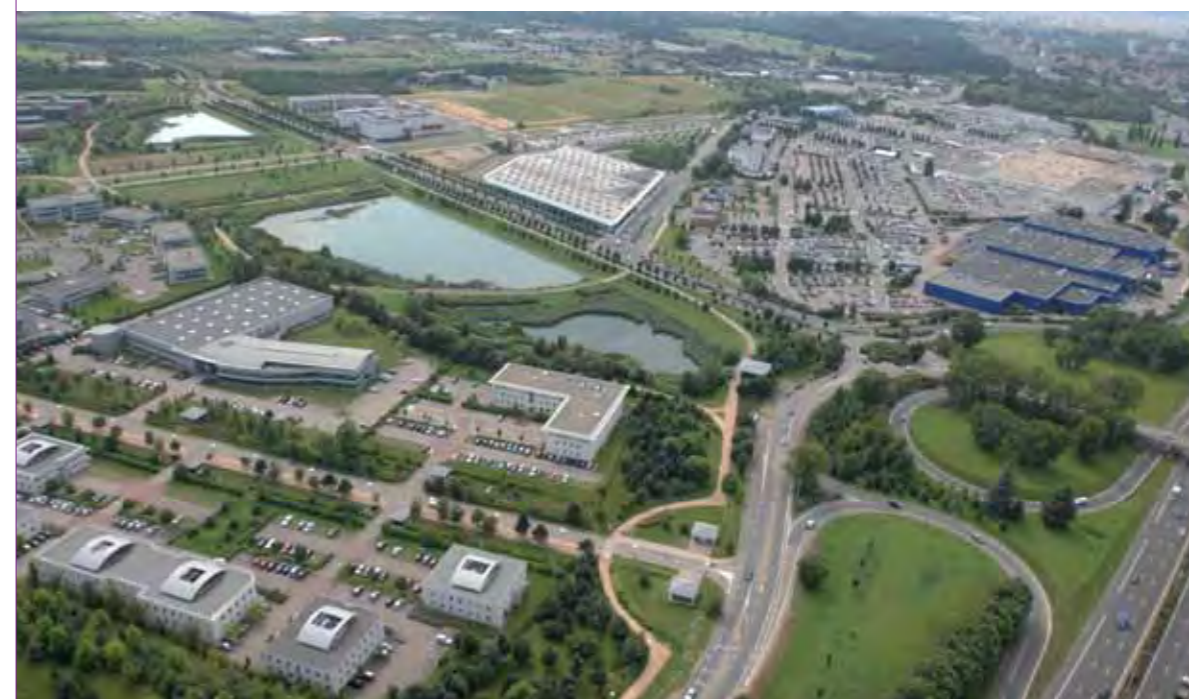
Zone d'activité commerciale et tertiaire de Porte des Alpes à Saint-Priest, en bordure de l'autoroute A43. © Jacques Léone - Grand Lyon
