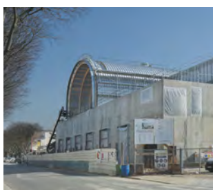
Photo du chantier - mars 2019
