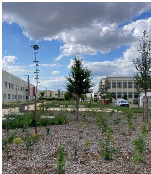
Solution enterrée (bassin d'infiltration), USIN Parilly à Vénissieux
