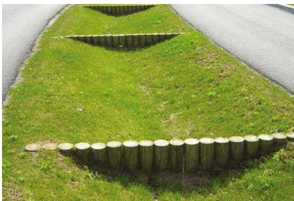
Noue enherbée avec cloison en bois
