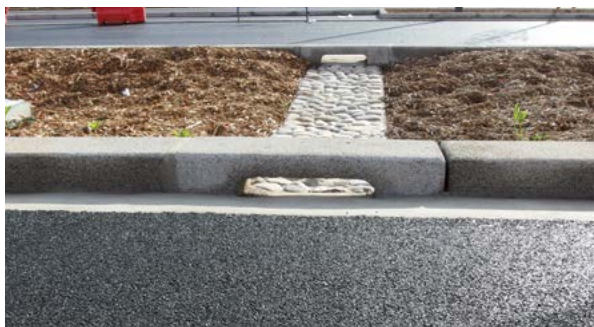
Zone d'entrée d'eau dans une noue (bordure ouverte et enrochement)
