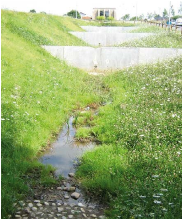
Noues avec cloison pour optimiser le stockage
