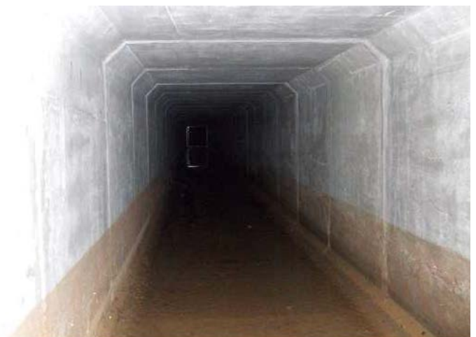
Ste Foy, bassin en cadres préfabriqués et la ligne des plus hautes eaux atteintes
