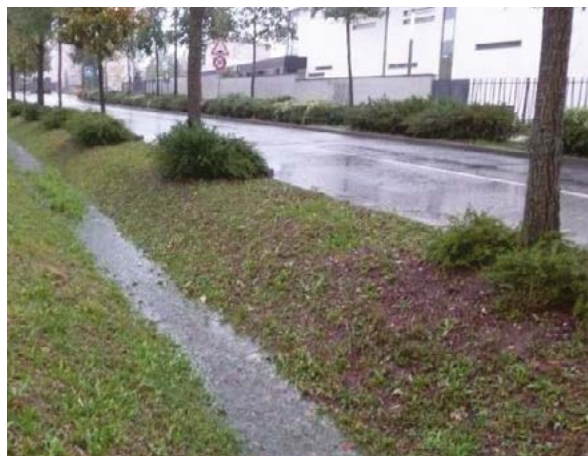
Noue en eaux lors d'un évènement pluvieux
