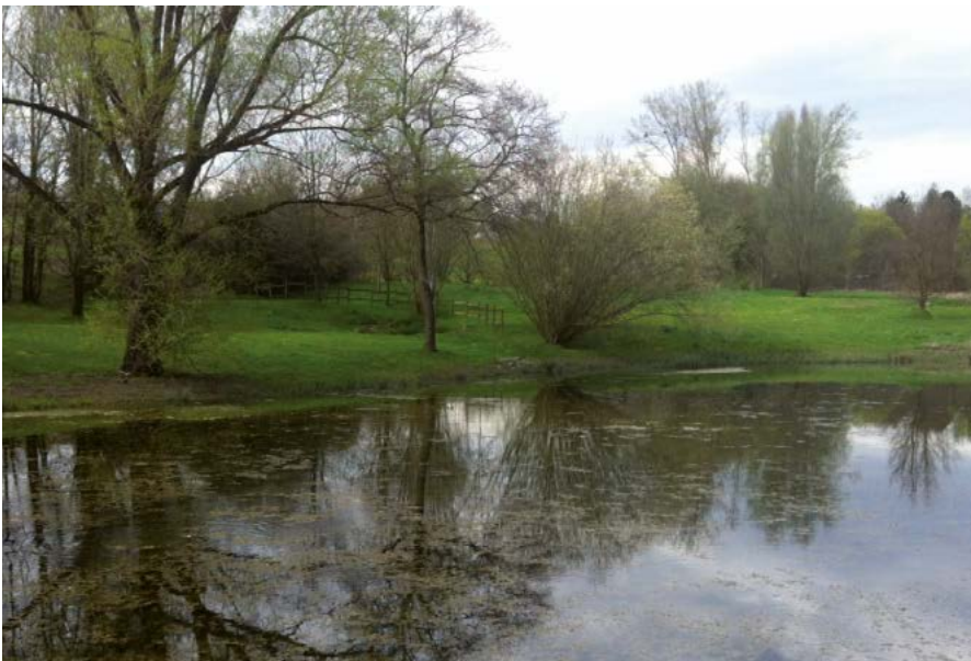
Bassin de rétention du Godefroy à Dardilly
