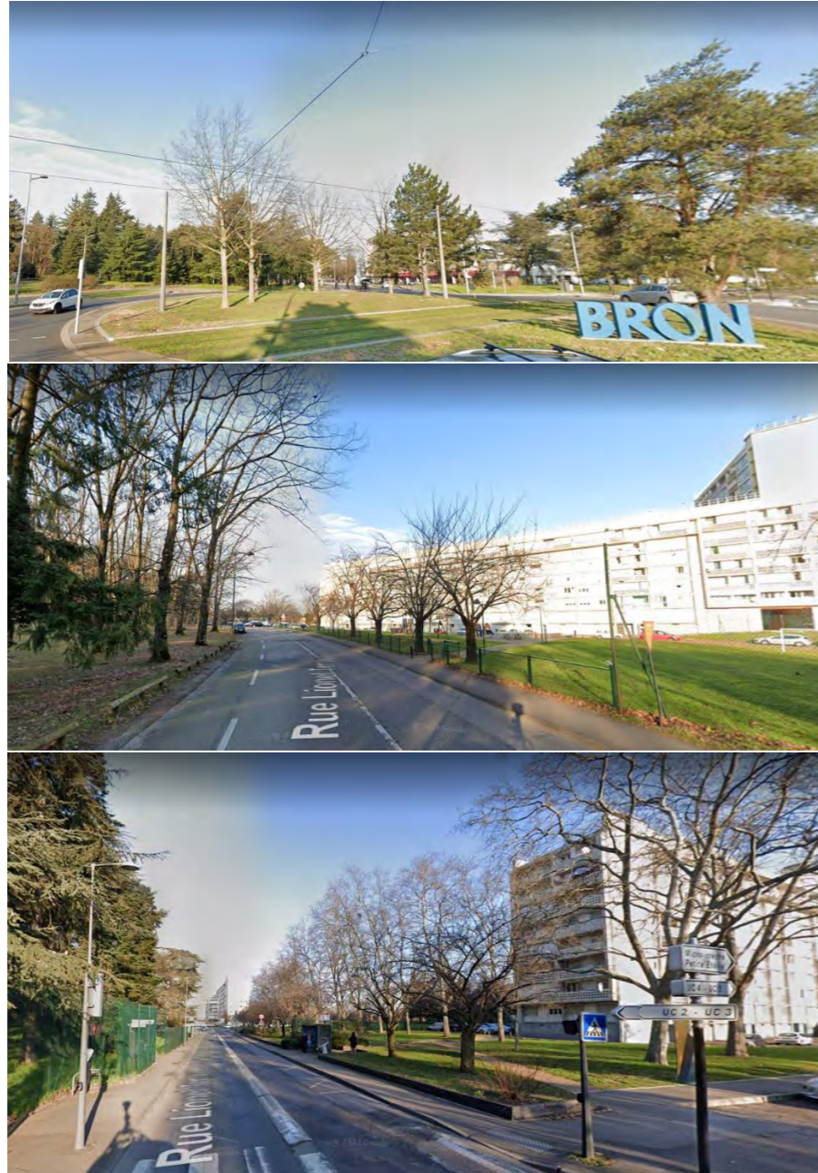
Photos prises sur la rue Lionel Terray (Source : Google street view)
