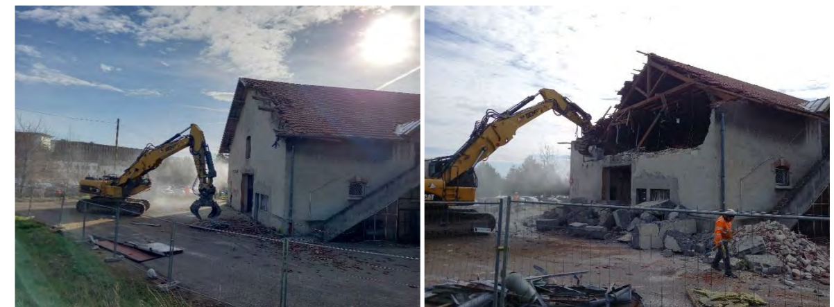
Illustration de la démolition progressive d'un bâtiment (chantier du Vallon des Hôpitaux) © EODD, 2021
