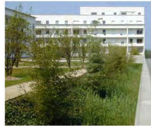
Espace en creux planté, Bruel Delmar
