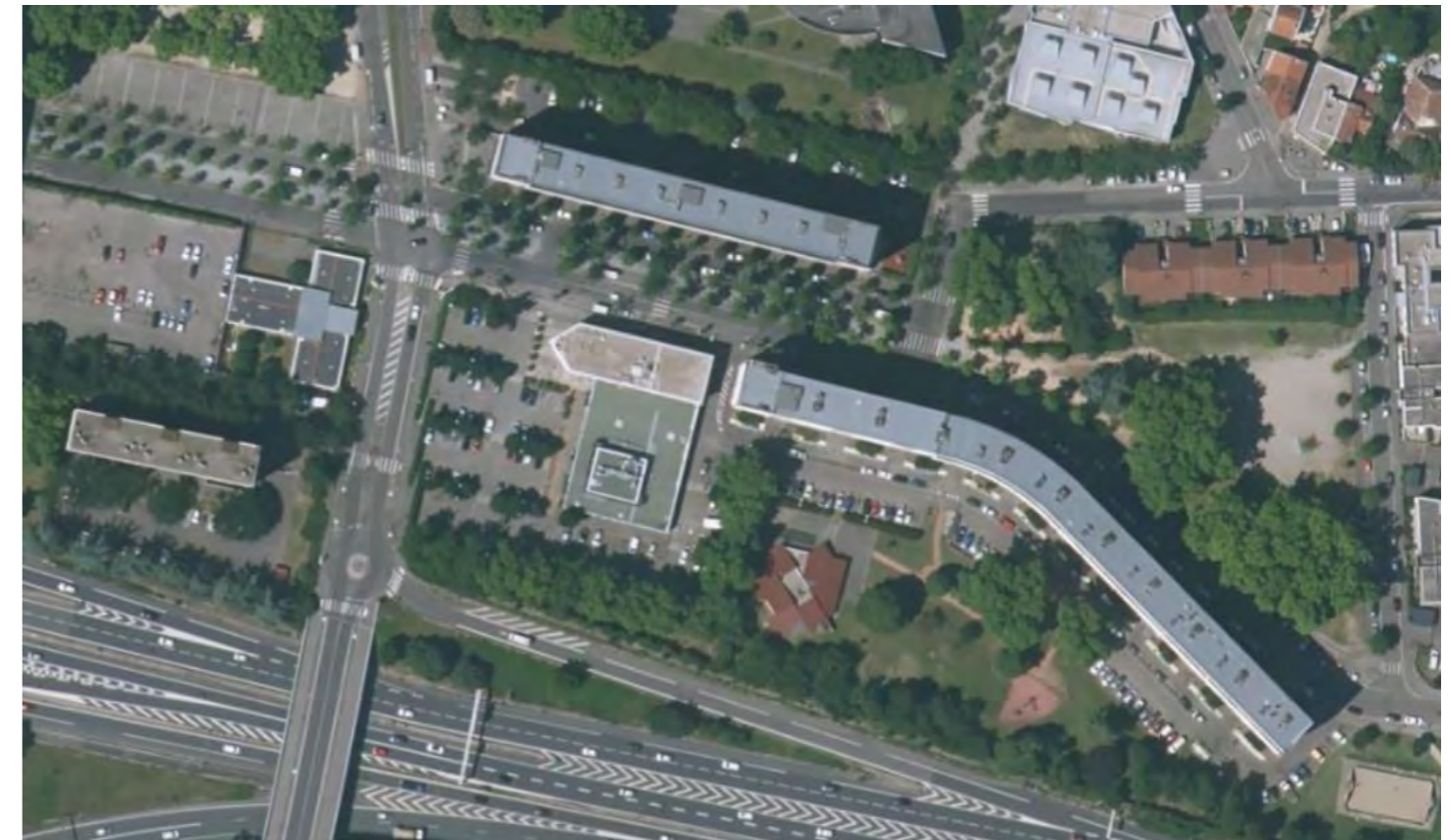
Illustration des stationnements sur Parilly Nord (Source : vue aérienne Géoportail)
