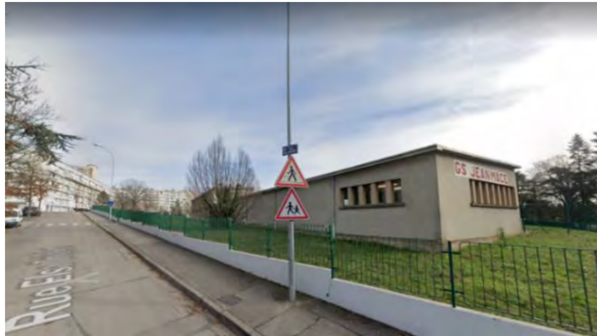
Groupe scolaire Jean Macé (Source Google street view)
