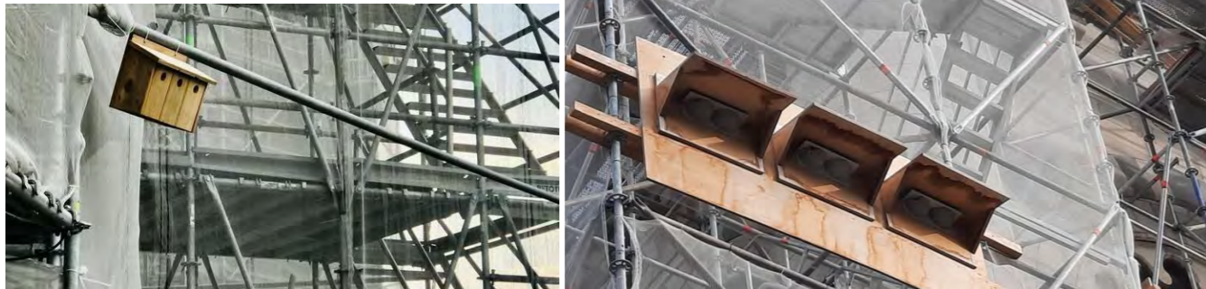
Nichoirs à Moineau domestique et à martinets sur des échafaudages (Source : Ville d'Angers, ministère de la Culture)
