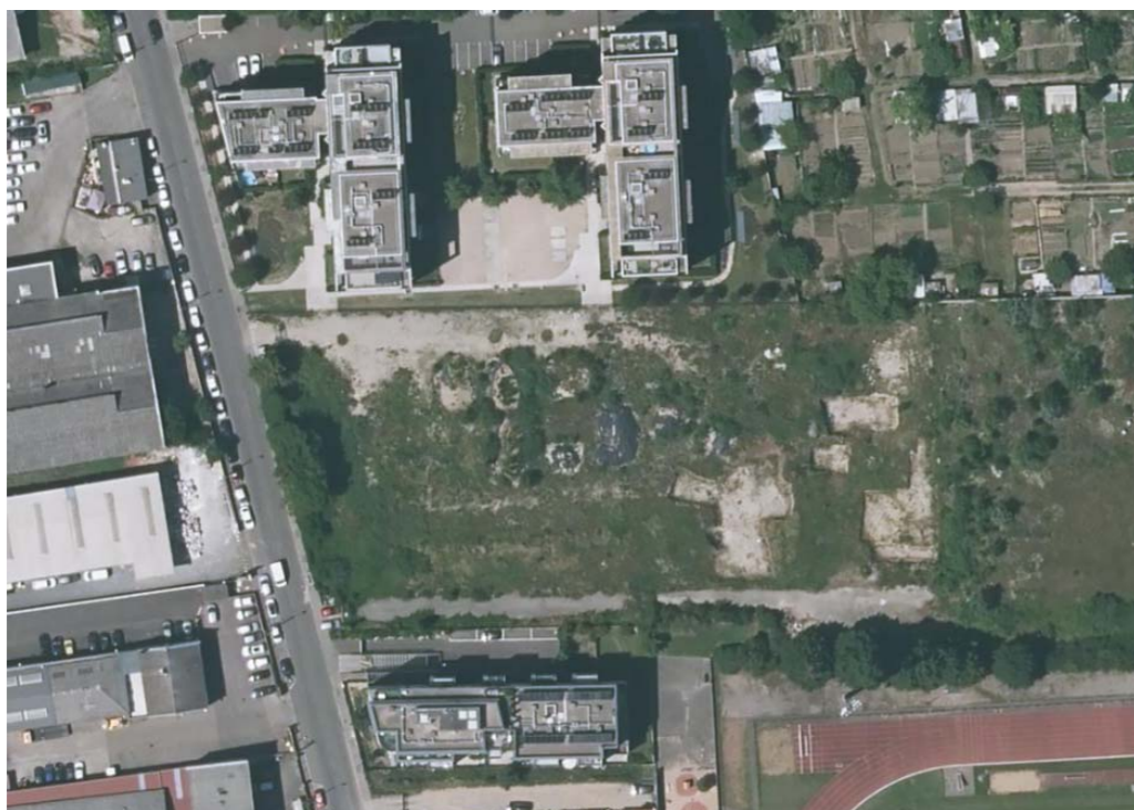
Vue aérienne de l'arche de Teodora, 59-69 rue de Verdun (Google Maps, 2024)
