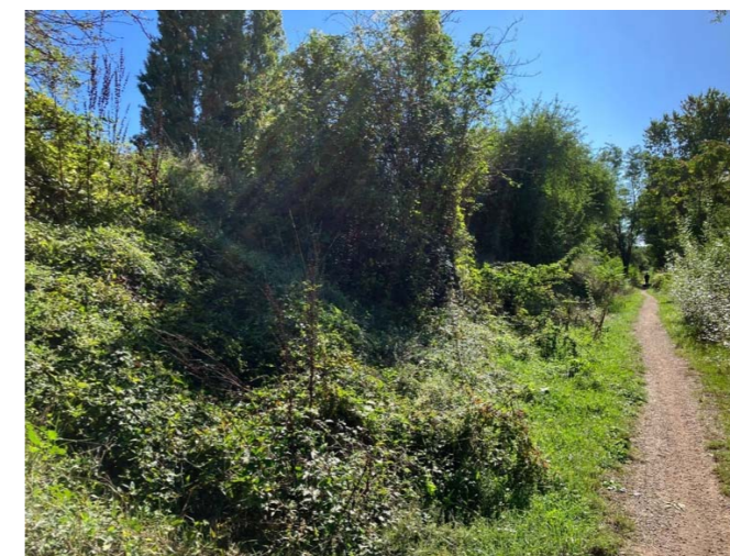
Figure 14 : Vue sur la digue Saint-Jean depuis la risberme chemin de halage
