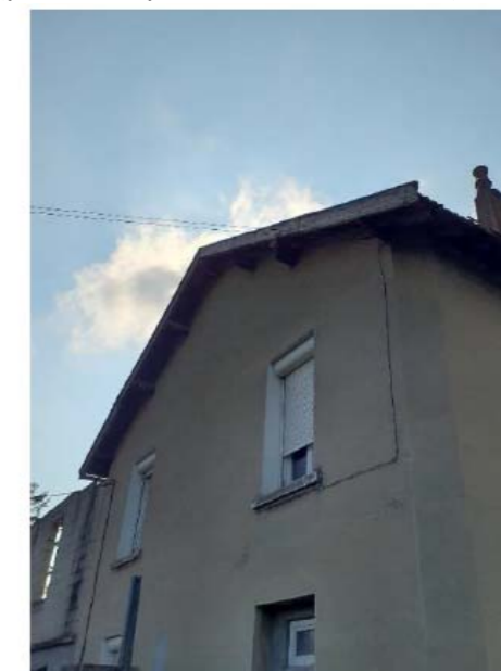
Habitation favorable au gîte dans les bâtis
