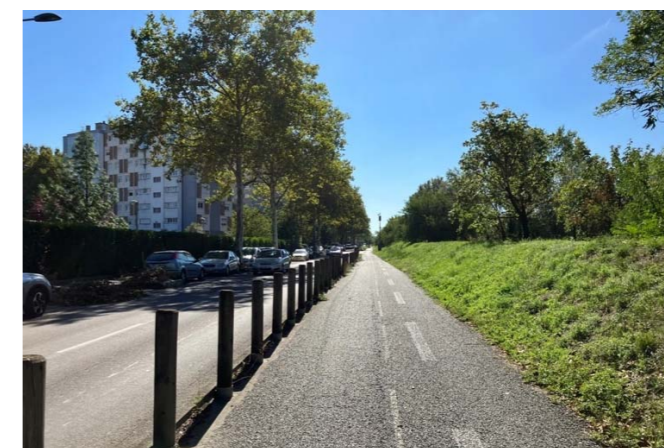
Figure 15 : Vue sur la digue Saint-Jean depuis la rue du Canal
