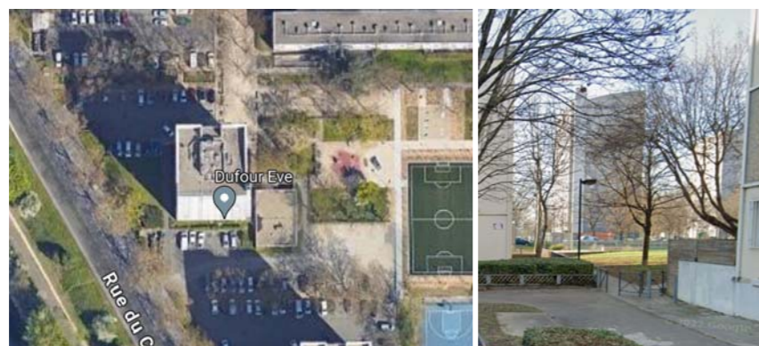
Chaufferie de la résidence Saint-Jean)
