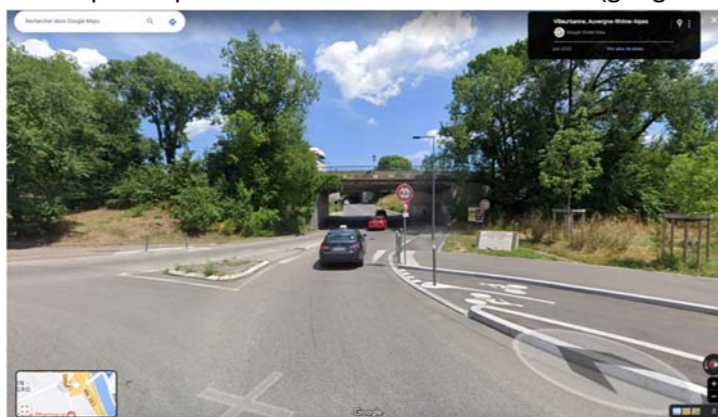
Vue de la trémie routière côté carrefour giratoire Charles de Gaulle en direction de Saint-Jean (google street)
