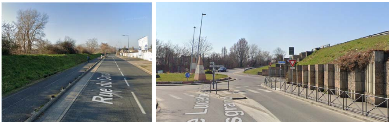
Les microreliefs exercés par la présence du canal de Jonage et sa digue (à gauche) ainsi que les remblais techniques de l'autoroute A42 (Google, Février 2022)
