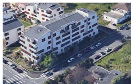
Vue aérienne sur l'allée du Mens et la façade nord de la copropriété « Les jardins du Mens » (google Maps, 2024)
