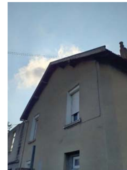
Habitation favorable au gîte dans les bâtis
