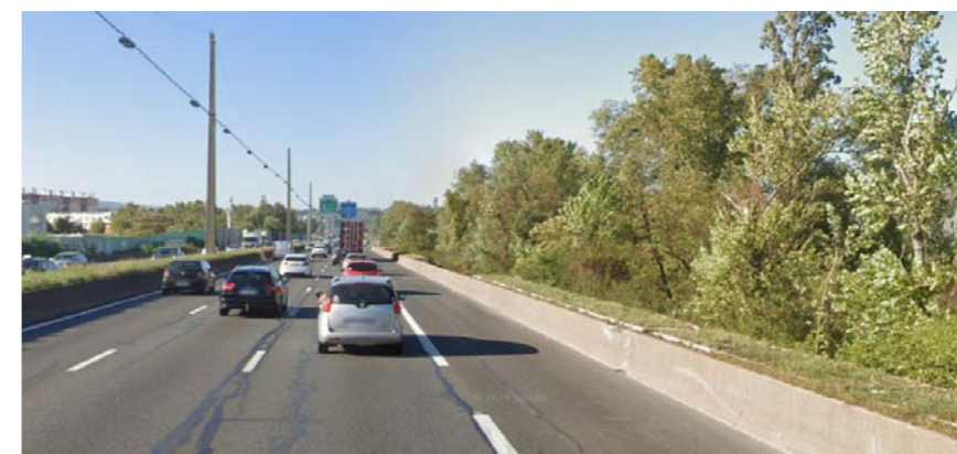
La Glissière en Béton Armé (GBA) qui assure une protection plus importante que la digue
