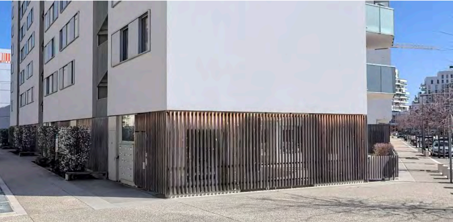
Locaux OM ( et vélos ) : des espaces naturellement éclairés et ventilés
