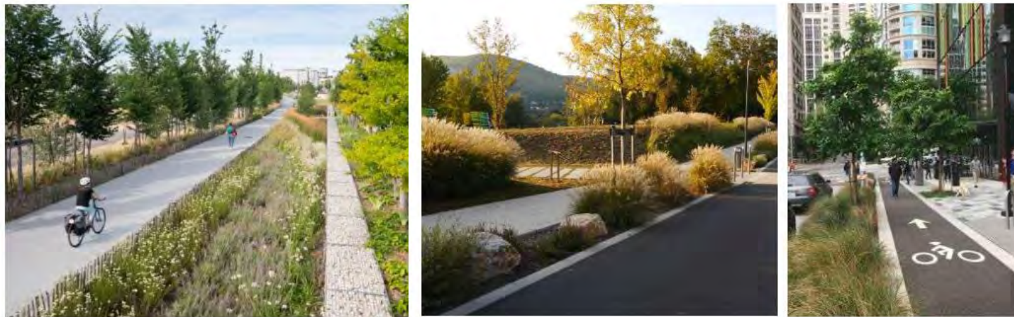
Figure 15 : Exemple d'aménagement de voies cyclables séparées de la voirie par des espaces plantés (ex : affluent Boileau) (Source : Programme graphique des espaces publics - Grand Lyon)
