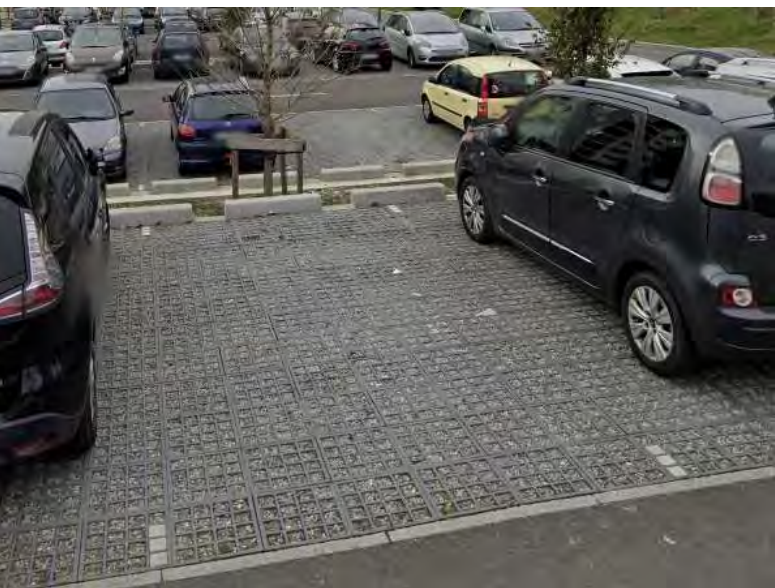
Le gravier comme matériau poreux pour les places
