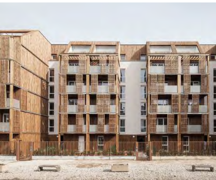
Un système d'occultation solaire et une gestion de l'intimité au langage architectural commun Guerin Pedroza architecte, 50 logements BBC, Bondy
