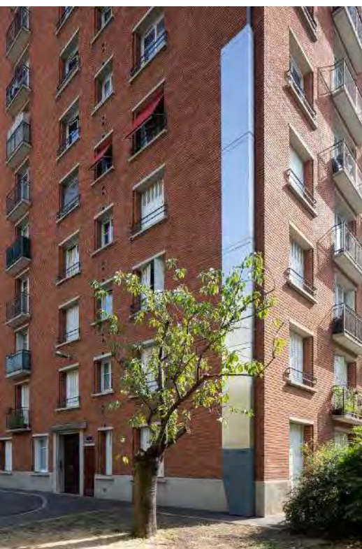
Réservoir d'eau de façade Reenstok installé en façade d'un bâtiment existant ( Paris 10e ) Réutilisation des eaux de pluie pour arroser les espaces verts + jardin partagé
