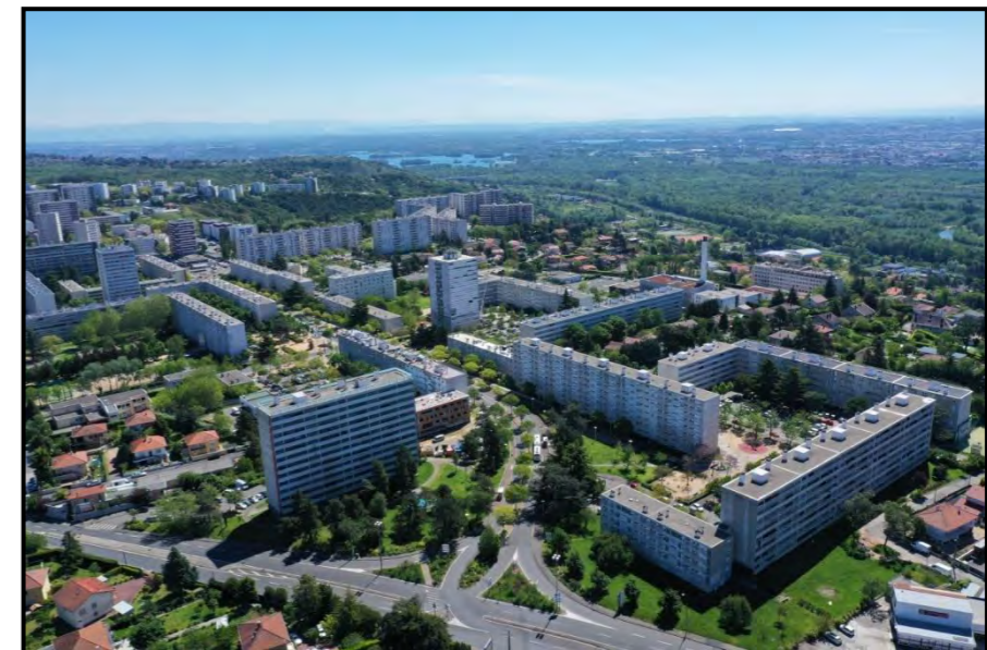
Figure 168 : vue aérienne oblique du quartier des Alagniers (© Balloïde Photos)
