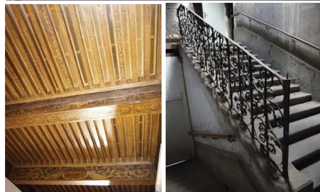
Château de Longchêne (façade Nord), plafonds peints du rez de chaussée et ferronnerie de l'escalier des combles (Source : étude patrimoniale, Cécile Rémond)
