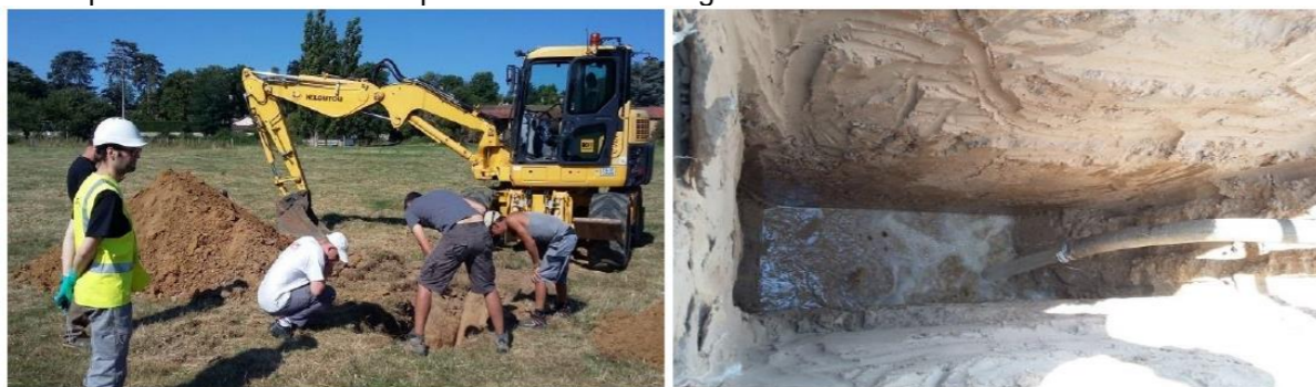
Creusement de la fouille et remplissage avant mesure (source : BURGEAP)
