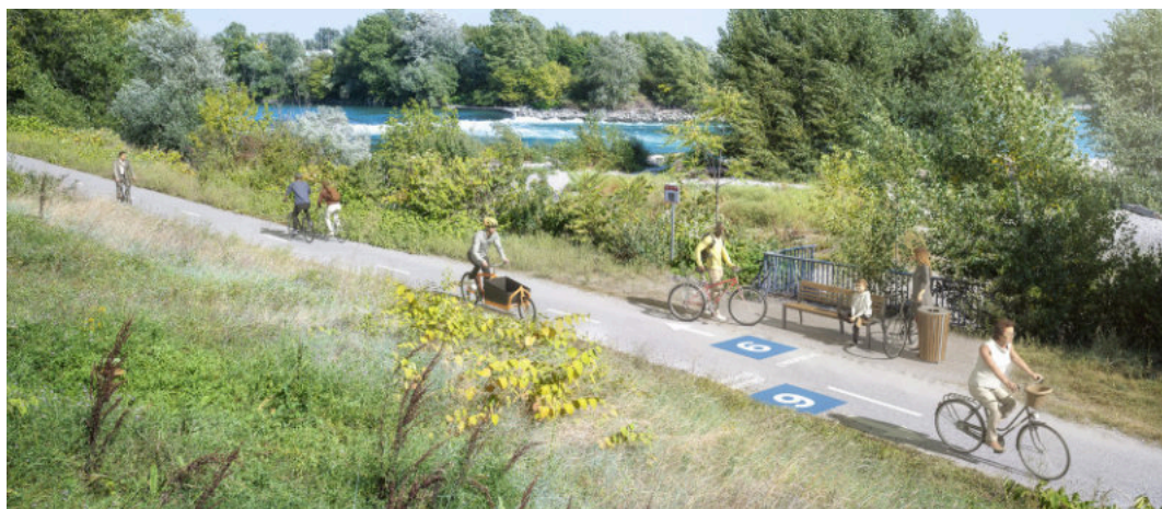
Perspective des aménagements réalisés pour la ligne 6 - Seuil de la Feyssine, horizon 2026
