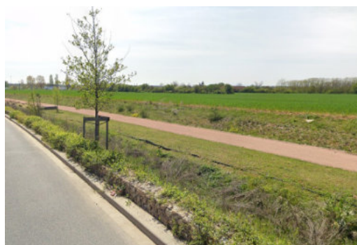
Exemple de terre-plein végétalisé large entre chaussée et aménagement cyclable, traité en noue.
